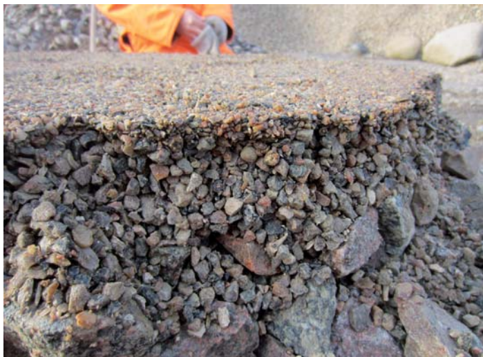
Som alternativ til stabilt grus, opbygges permeable bærelag af knust materiale. Foto fra test i Stenrand Grusgrav med permeabel tre-lags opbygning: 2-3 mm på 5-8 mm skærver og 32-45 mm skærver i bunden.
