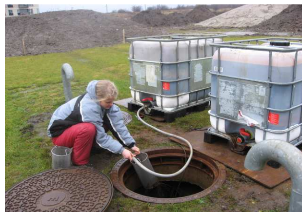
Step 2 - Tilsætning af okkerslam til DPF-6-Lag indløb under recirkulering.
