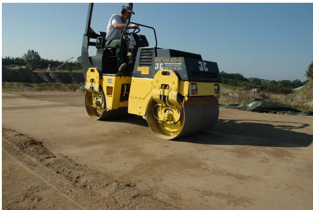
Figur 12. Komprimering af Slotsgrus med tromle i forsøgsfelt (fotograf: Palle Kristoffersen, Skov & Landskab - KVL).
