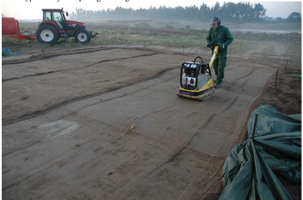
Figur 11. Komprimering af Slotsgrus med pladevibrator i forsøgsfelt (fotograf: Torben Dam, Skov & Landskab - KVL).
